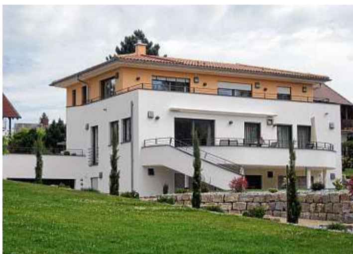
Über Außentreppen kann man ohne Probleme in die verschiedenen Stockwerke gelangen.
